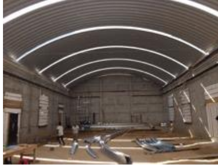
-Iglesia Católica Construcción Cubierta San Lucas Toliman 400.00 m 2
